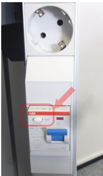
Obrázek 4 Kontrolní tlačítko proudového chrániče (RCD)
