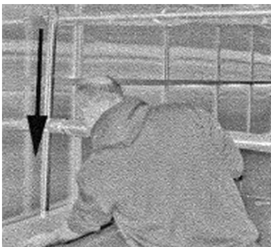
Bild 18 Stecken Sie die Standrohre in die Muffen ein.
