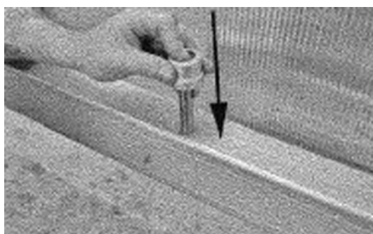
Bild 16 Stecken Sie die Schraube M8x130 in die Muffe und durch die Metallhülse hindurch.
