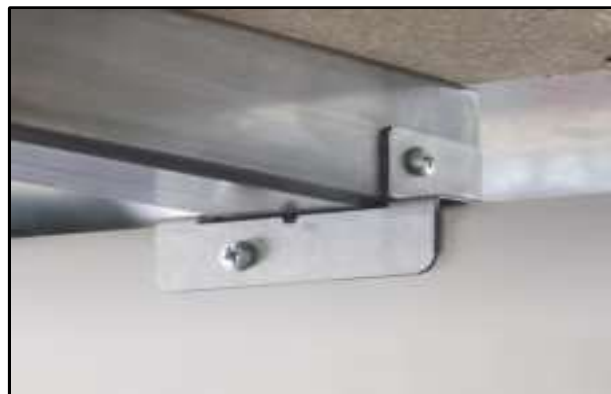
Befestigung der Spanplattenunterstützungsträger mit « Doppel U »-Profilen
