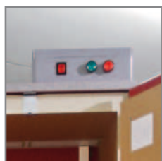
Steuereinheit mit Branddetektion Störungsmeldung über optisches Signal und Abschaltung des Lüftungssystems.
