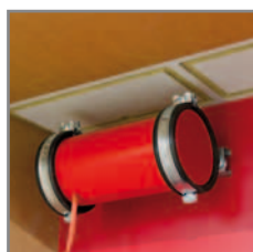
Löschgenerator Stromunabhängige Auslösung bei Feuer und unzulässiger Temperaturerhöhung.
