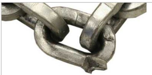
Das Kettenglied ist mechanisch beschädigt.
